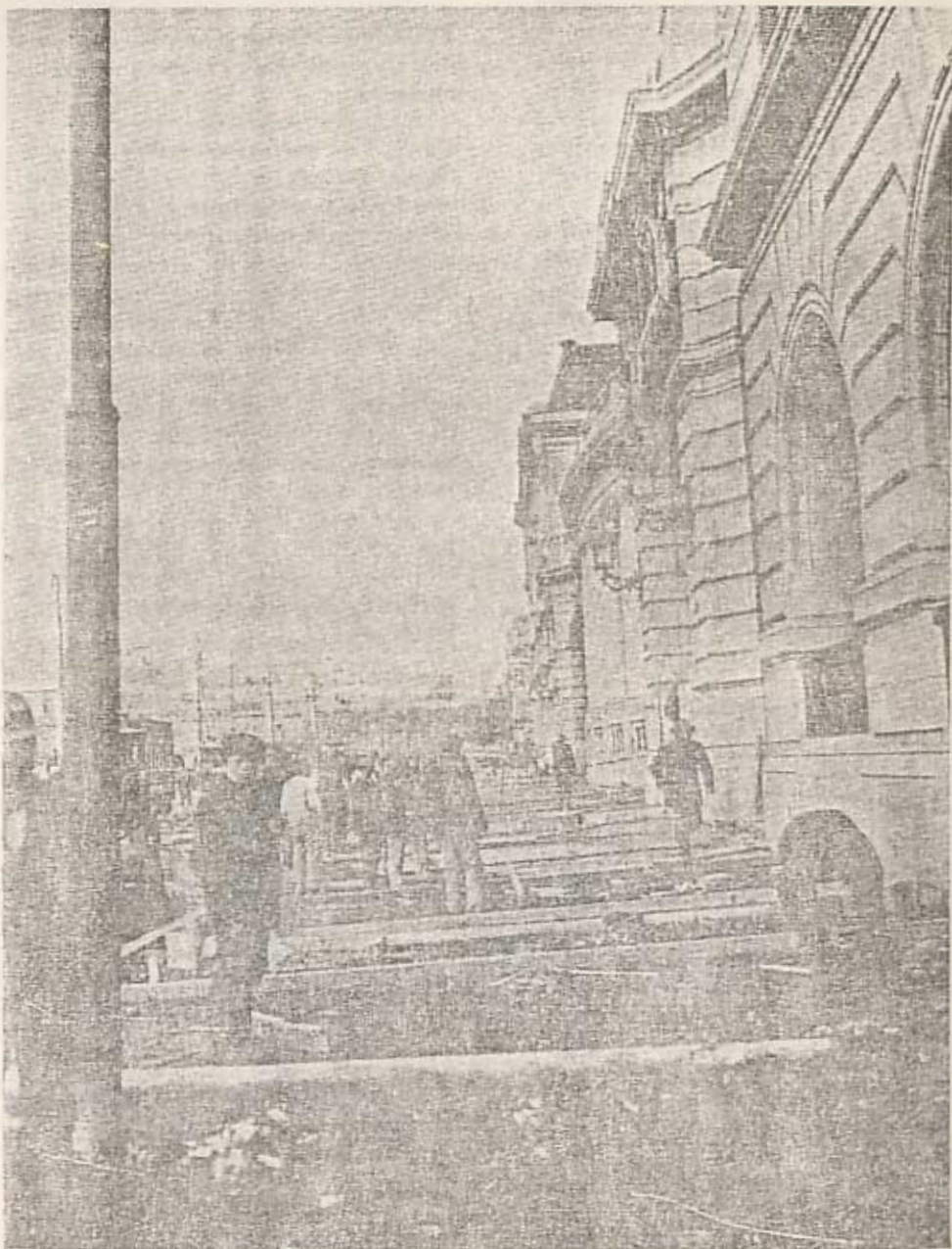
Construcción de la vereda sobre el frente del edificio ubicado sobre la actual Av. J. M. Ramos Mejía.
